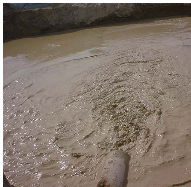
Schlammteich / Sludge lagoon
